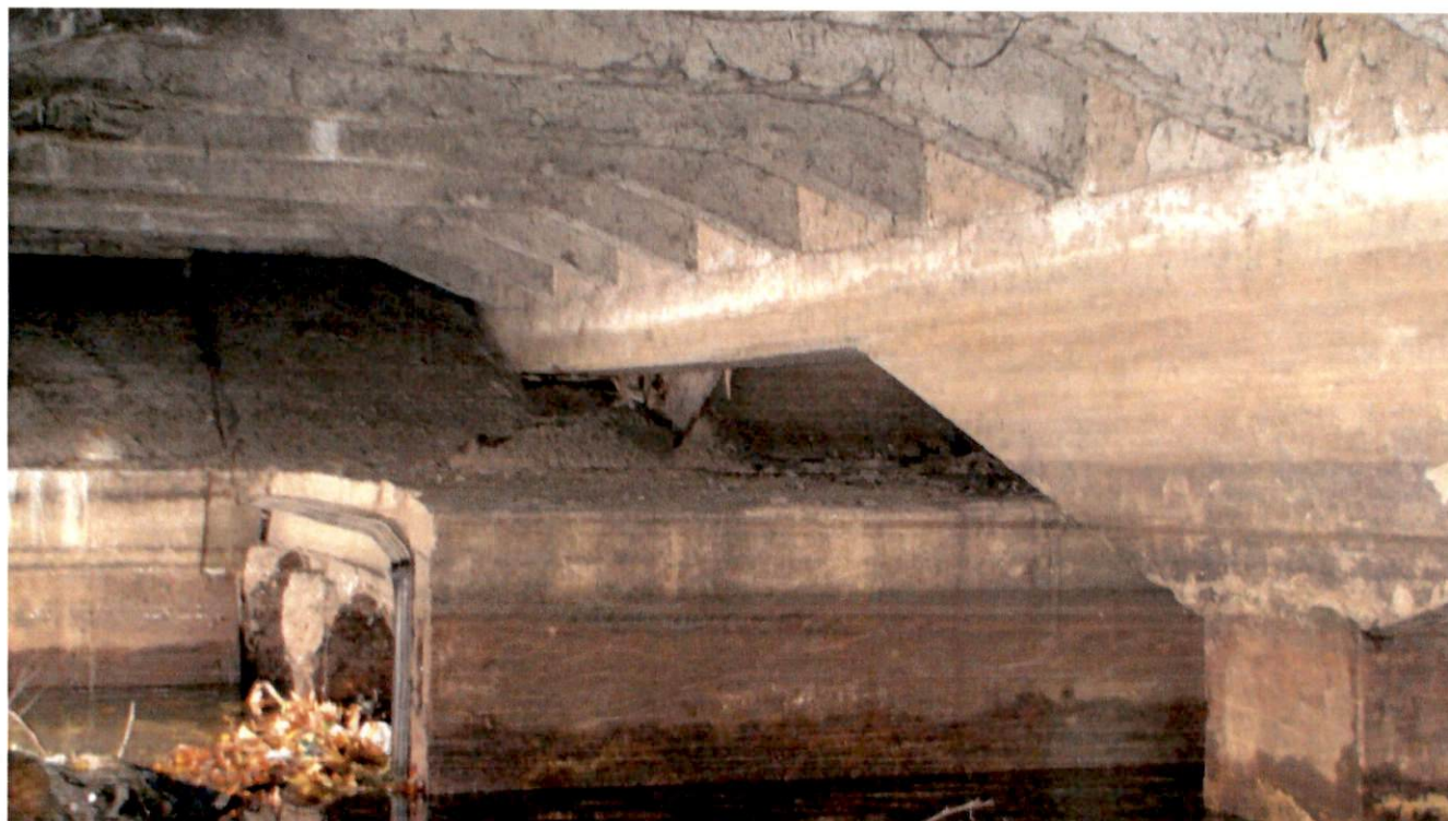
Fotografia 18 – Vedere zona amonte mal stang, in zona tuburilor
