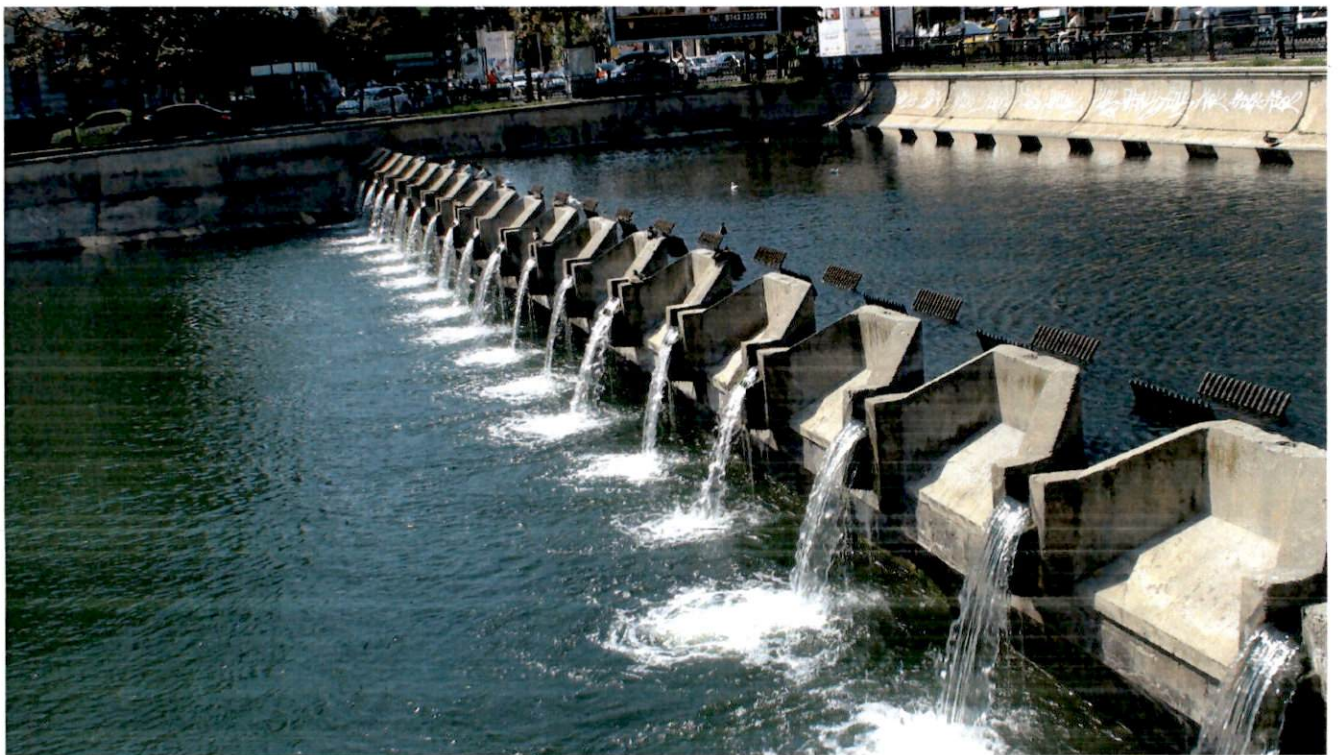
Fotografia 2 – Vedere planseu zona aval
