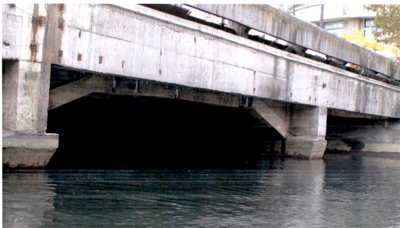
Fotografia 19 – Vedere zona amonte mal drept
