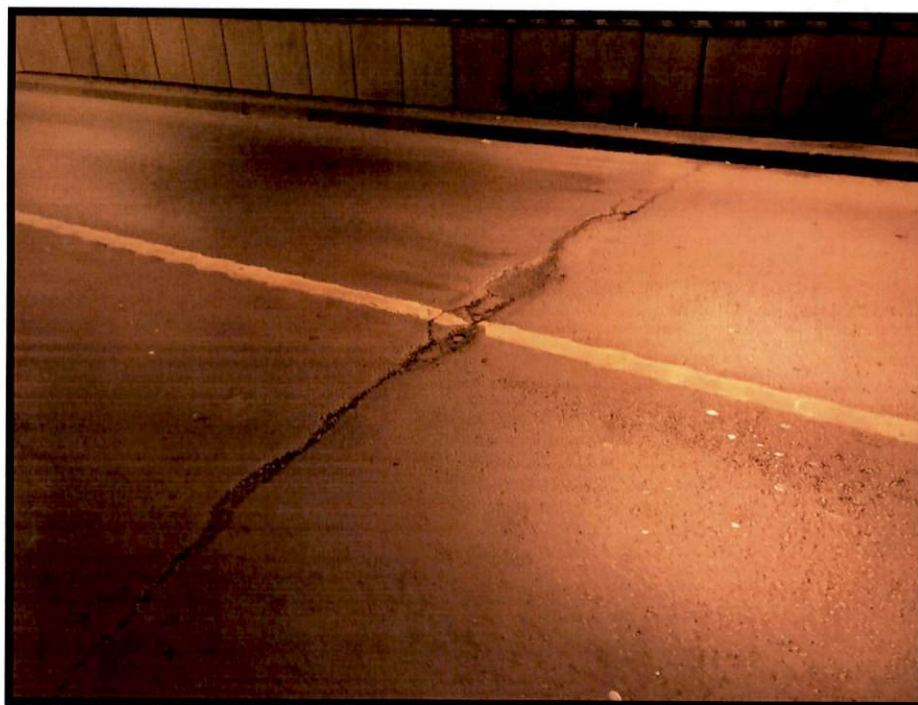
Foto 18 - Fisuri transversale
