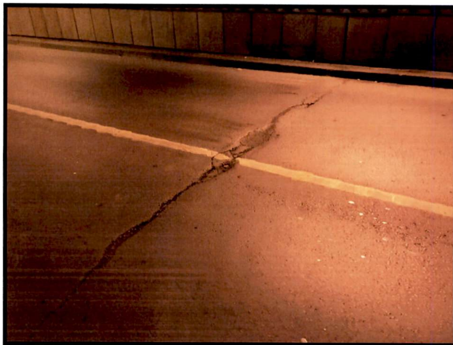
Foto 17 - Fisuri transversale
