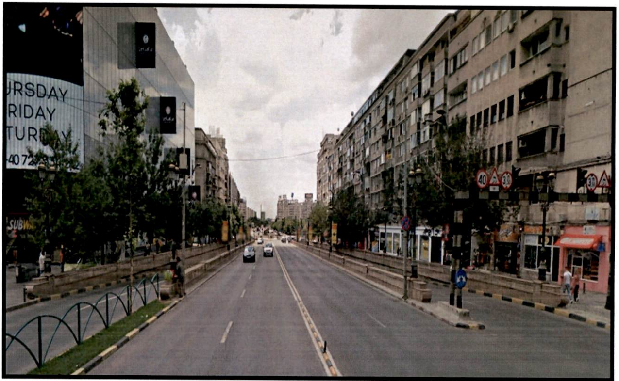
Foto 1 – Vedere rampa I.C. Bratianu
