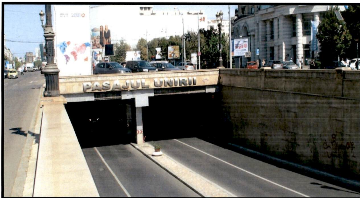
Foto 2 – Vedere rampa D. Cantemir
