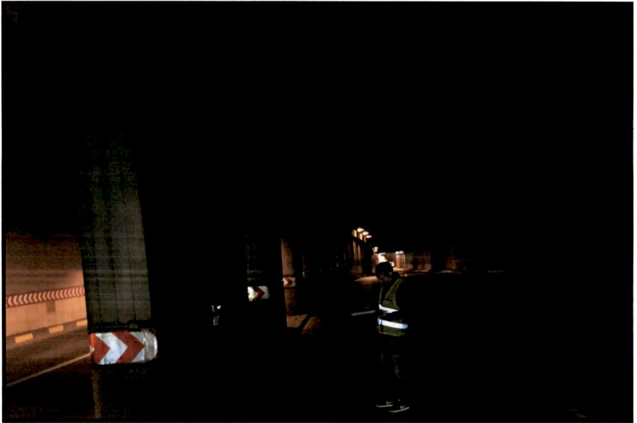
Foto 23 – Nefunctionalitatea sistemului de iluminat in interiorul pasajului
