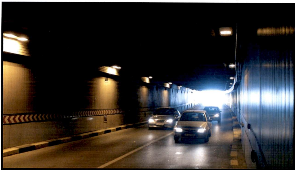
Foto. 4 – Vedere trotuare interior pasaj
