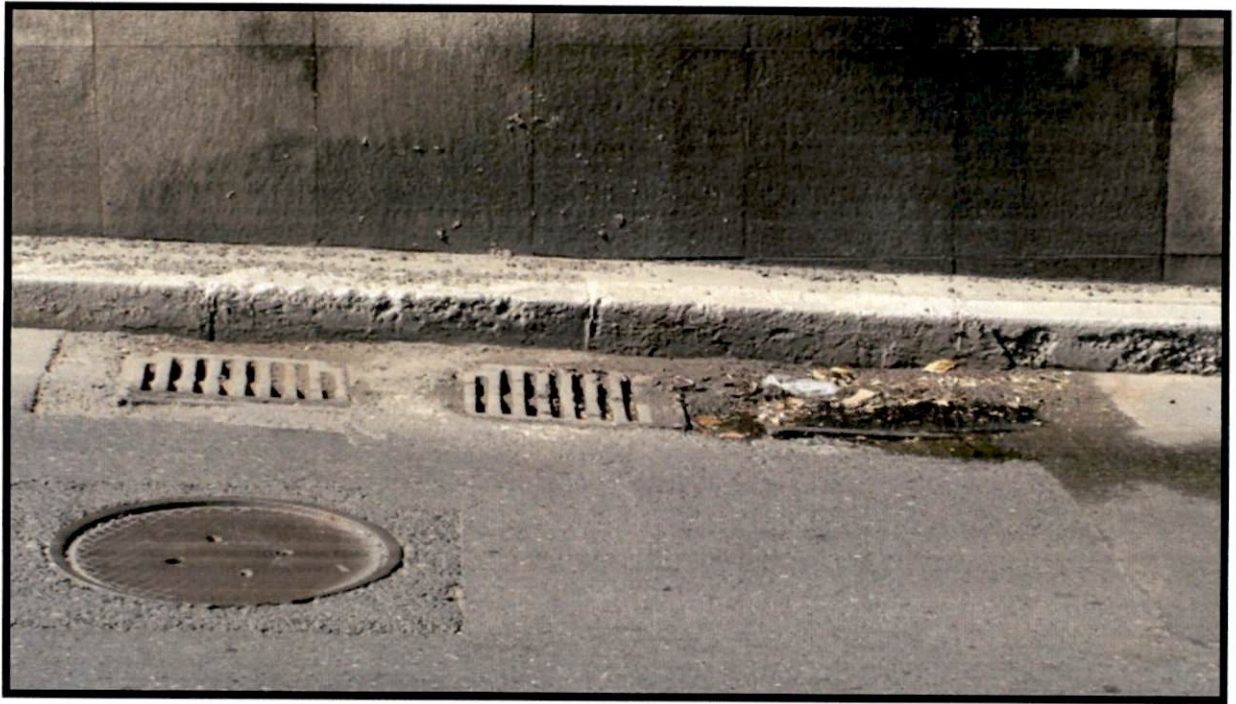
Foto. 3 – Vedere trotuar si guri de scurgere pe rampe de acces
