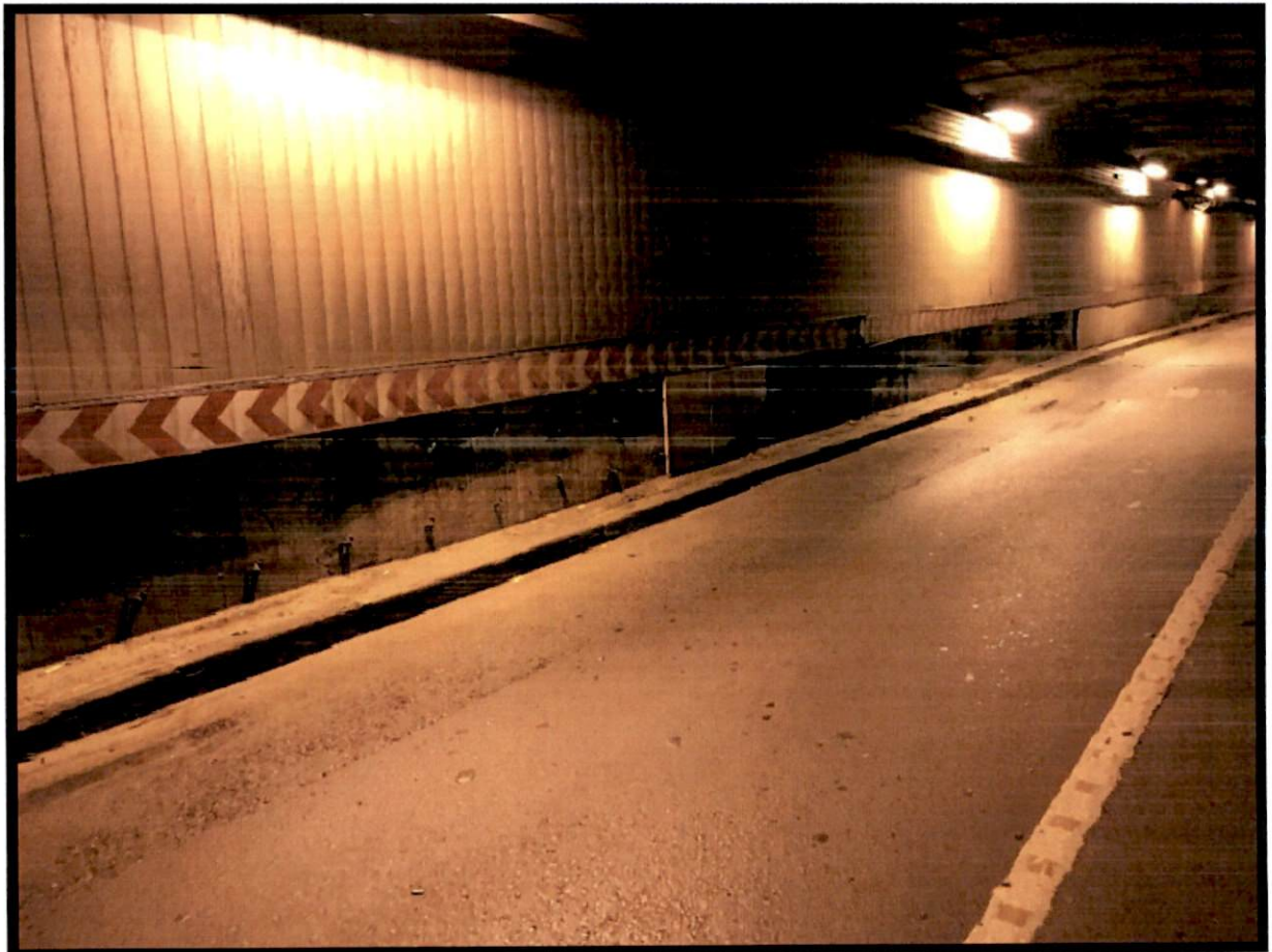
Foto 26 – Zone in care placajul de granit este desprins de pe suportii metalici
