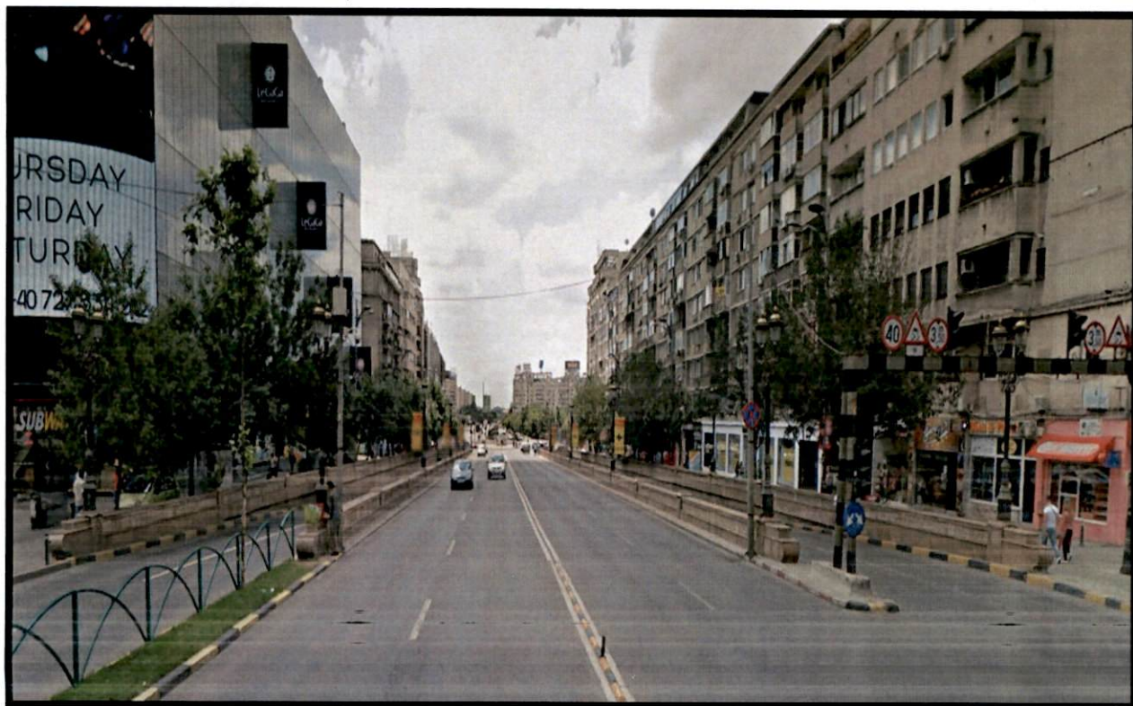
Foto 1 – Vedere rampa I.C. Bratianu
