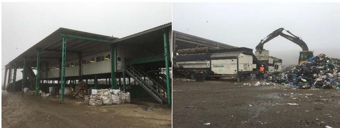
Figura 6. Statia de sortare SC ECO SUD SA
