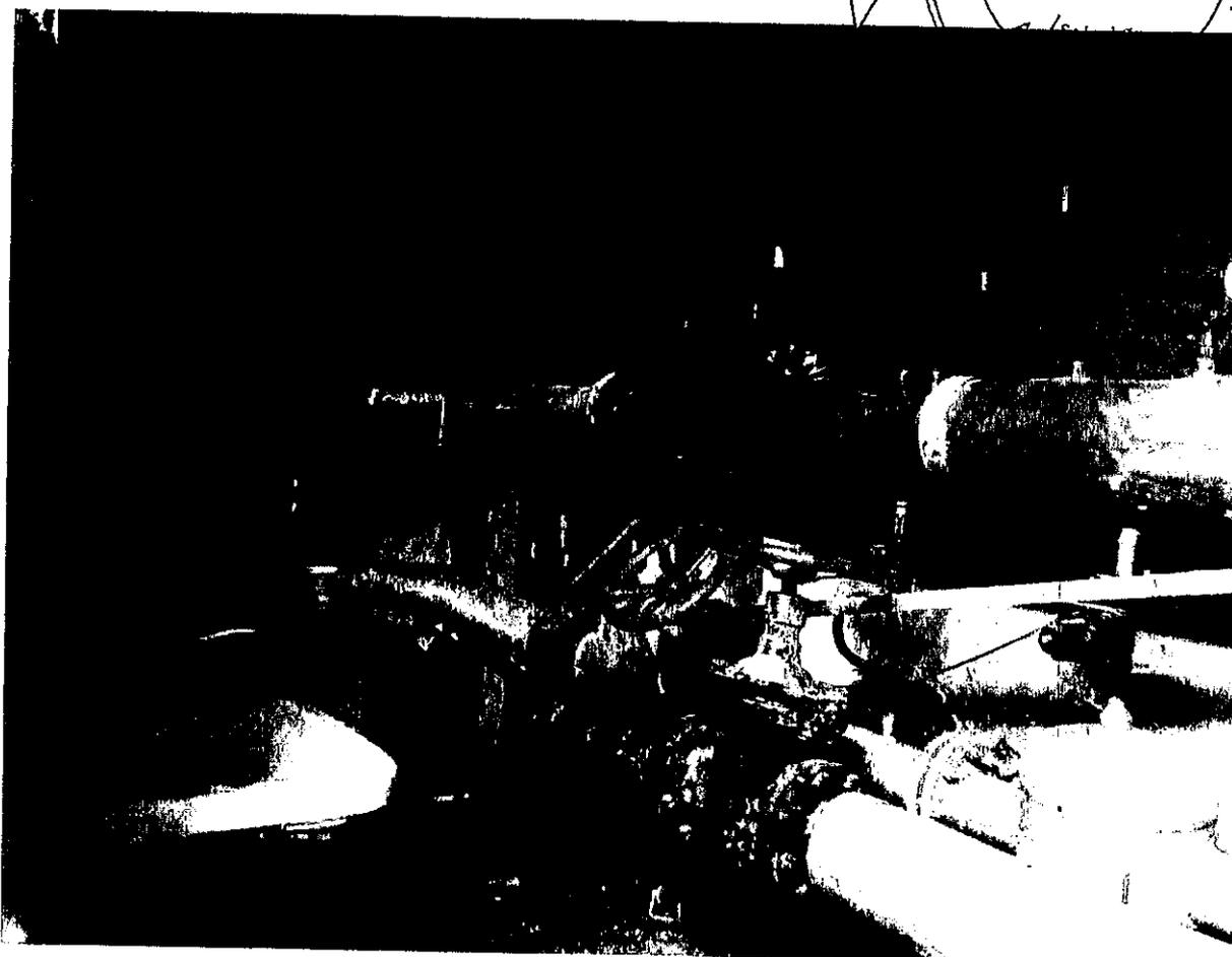
Figura – traseu de alimentare cu agent termic primar, care ajunge in camera echipamentelor termice in cladirea BIG BERCEI, amplaata subteran.
